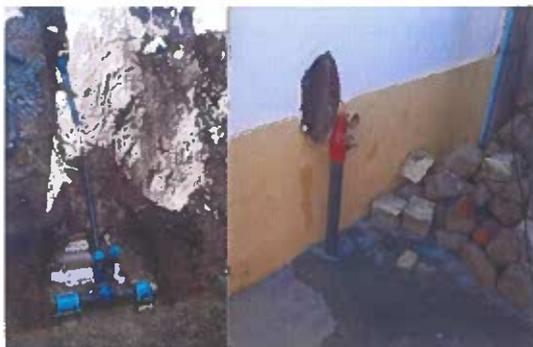
Figura 7. - Substituições de ramais de águas no concelho de Beja
