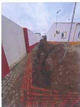
Figura 10. - Instalação conduta rua nova
