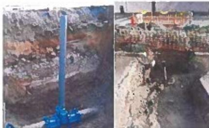
Figura 8. - Varios sectionamentos de rede intervencionados na rede de águas do concelho de Beja
